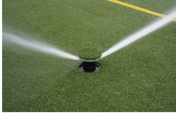
Şekil 19. Peyzaj sulamada kullanılan toprak altına döşenmiş yağmurlama başlığı
